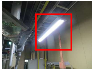
本社および白藤工場内 LED 化 (31 箇所)
