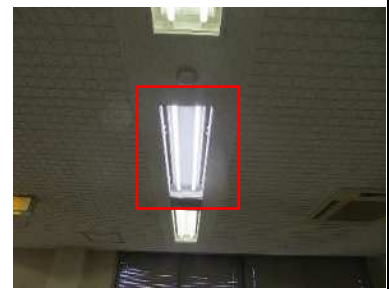
本社事務所 LED 化（1 箇所）
