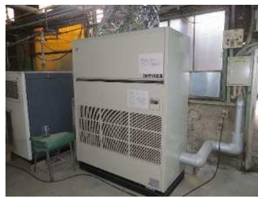
本社工場 新冷暖房空調装置
